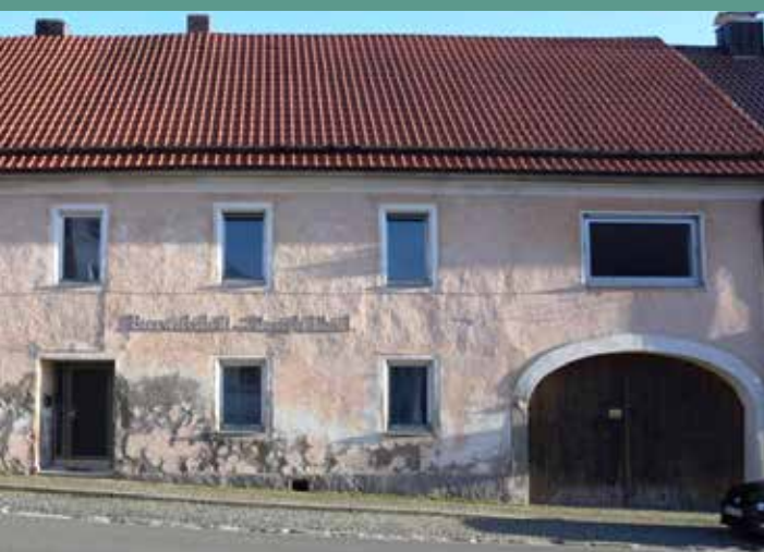
Marktplatz 13 vor und nach dem Umbau
