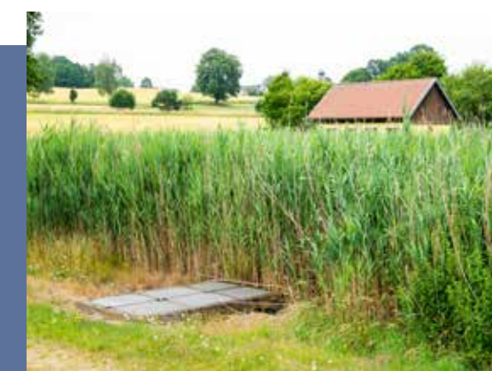
Pflanzenkläranlage in Albersrieth
